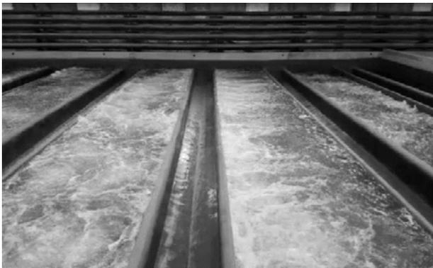
Figura 4.- Liberación de aire en forma de burbujas al finalizar la carrera de filtración
