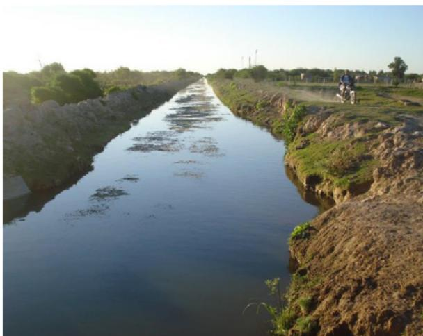
Figura 1.- Estado actual del Canal del Alto, con altísima concentración de algas y significativos procesos de sedimentación.
