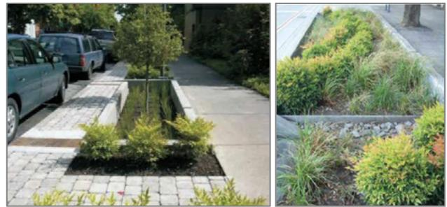
Figura 2.- Celdas de biorretención.
