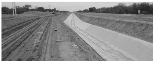
Figura 4.- Canal de derivación al Canal de Dios finalizado
