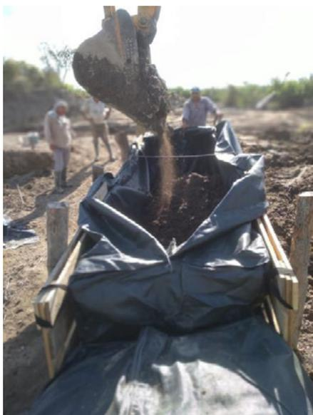
Figura 3.- Relleno en seco de geocontenedores
