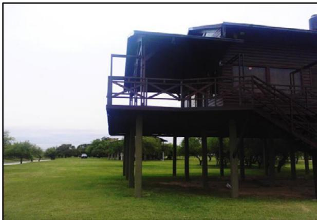
**Figura 3.-** Ejemplo de construcciones Palafíticas para viviendas no permanentes en zonas inundables.
