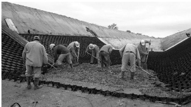
Figura 3.- Hormigonado de geoceldas en canal de derivación.
