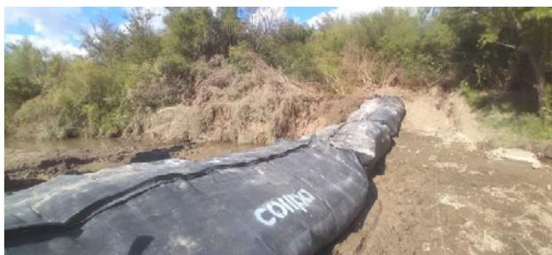
Figura 4.- Cierre de la sección del cauce con geocontenedores
