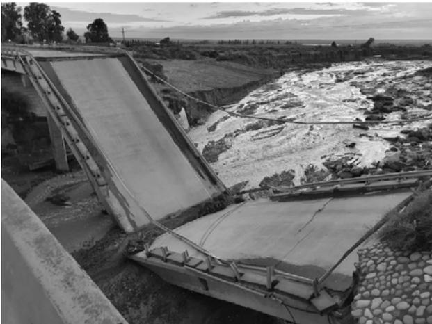
Figura 1.- Puente colapsado sobre Arroyo Los Pozos RN40.
