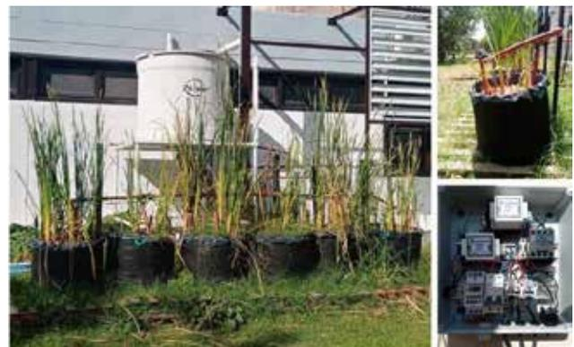
**Figura 1.-** Sistema de alimentación de 6 Humedales Construidos, sistema de riego y tablero de control.
