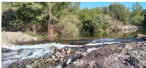
Figura 5.- Captación libre con azud de geocontenedores en funcionamiento
